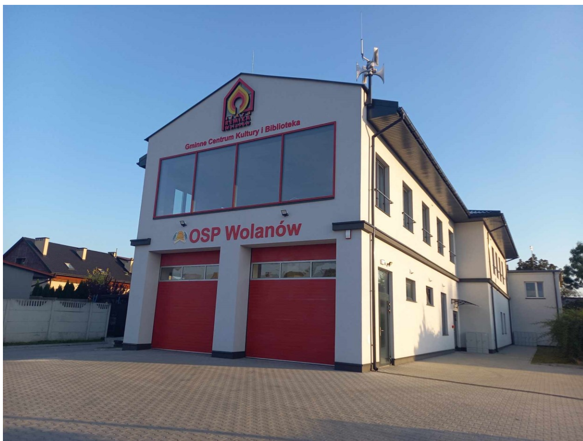
Odbudowana siedziba gminnego centrum kultury i remizy w Wolanowie
