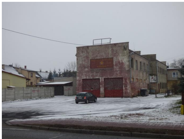
Fot. 2. Budynek Strażnicy w Wolanowie
